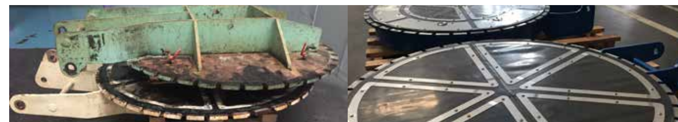
Remplacement de portes de réchauffeurs de jus
